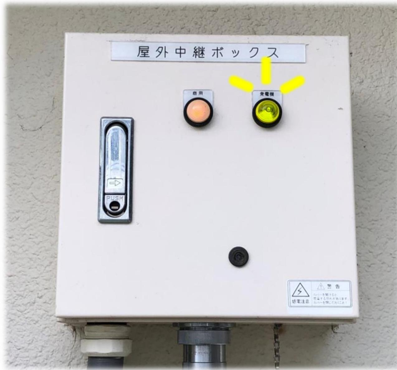
屋外中継ボックスの発電用の黄色いランプが点灯
