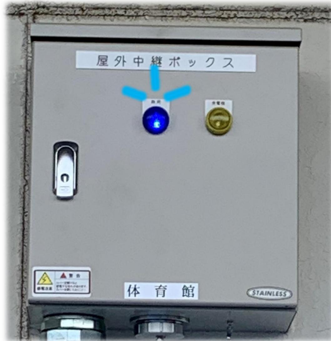
自動で屋外中継ボックスの「発電用」の黄色のランプが消え「商用」の青いランプが点灯
