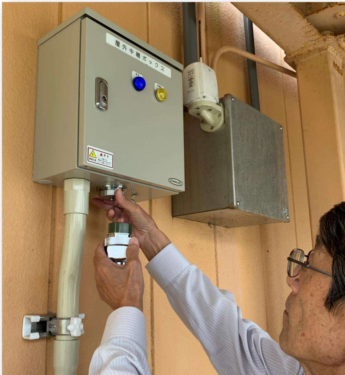
屋外中継ボックスに専用コンセントを接続
